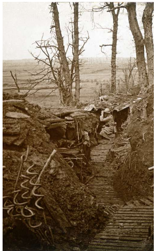
..... Dans le secteur des Épargnes, on peut voir que les tranchées étaient souvent faites de bric et de broc !
